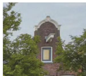
Рисунок 10 - Крюки для подъёма грузов на фасаде жилых домов. Голландия
