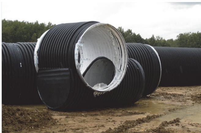
Рисунок 3 – Полимерная труба для ливневой канализации
