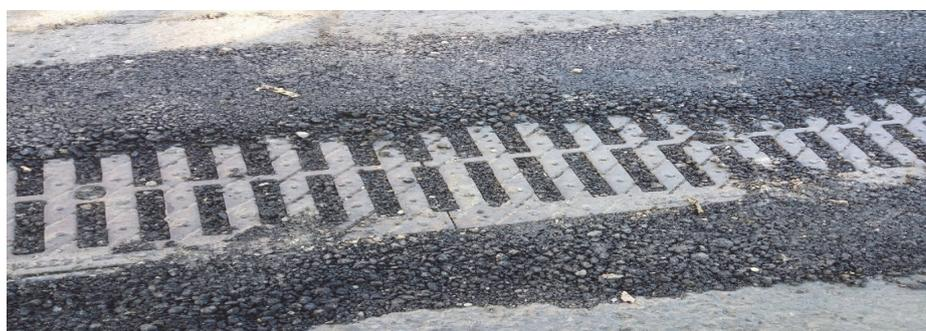
Рисунок 2 – Заасфальтированная решётка ливневой канализации
