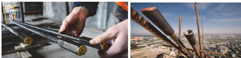
Рисунок 2 – Общий вид муфтовых соединений
