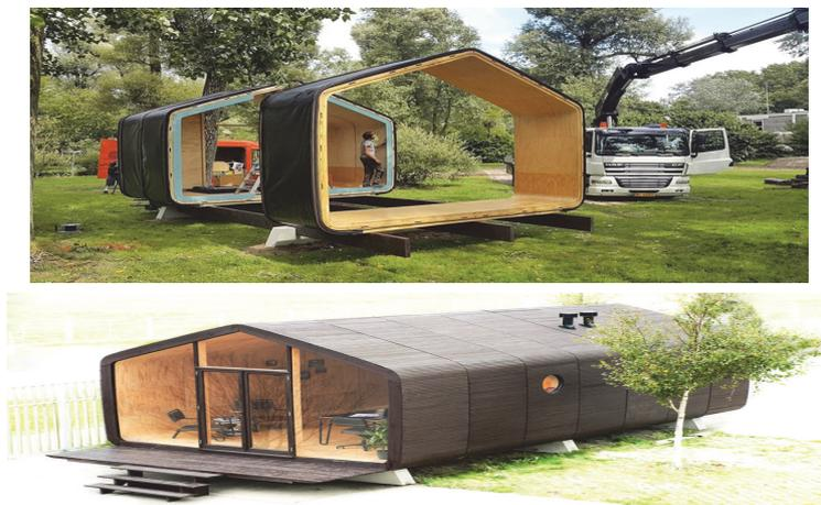
Рисунок 1 - Пример быстровозводимого модульного сооружения
