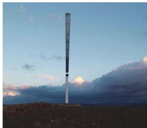
Рисунок 3 – Ветрогенератор с вертикальной осью вращения
