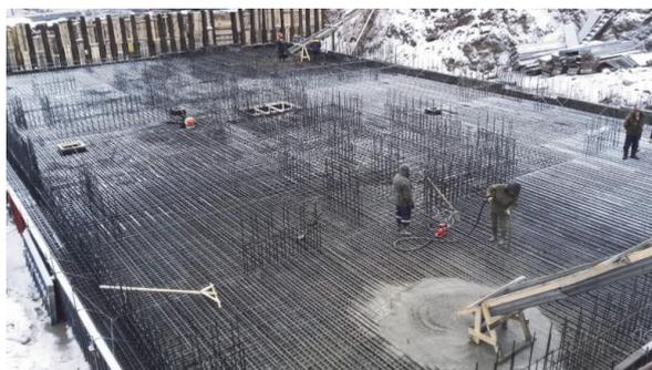
Рисунок 1 – Бетонирование в зимний период
