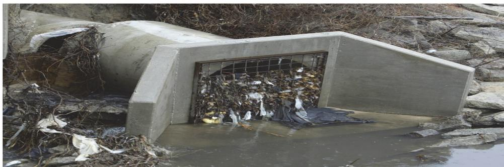
Рисунок 1 – Забитая мусором ливневая канализация
