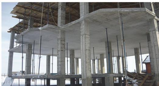
Рисунок 1 – Конструкция монолитного безбалочного перекрытия
