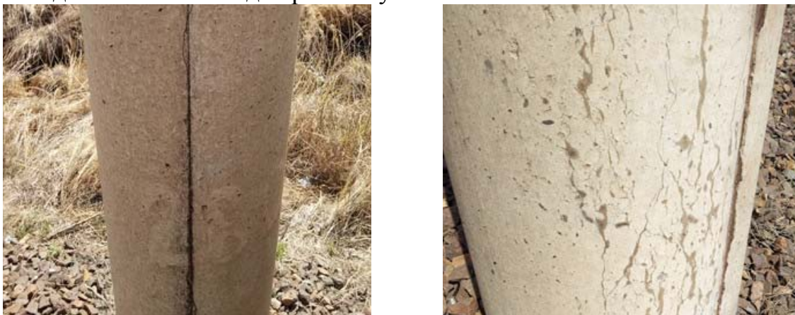
Рисунок 1 – Трещинообразование на поверхности опоры
