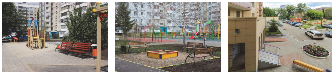
Рисунок 1 – Выполнен ремонт двора МКЖД, г. Белгород
